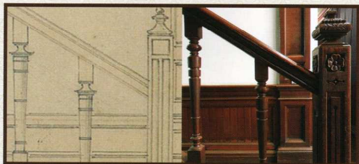
設計図と実際の内装(階段の手摺り)
